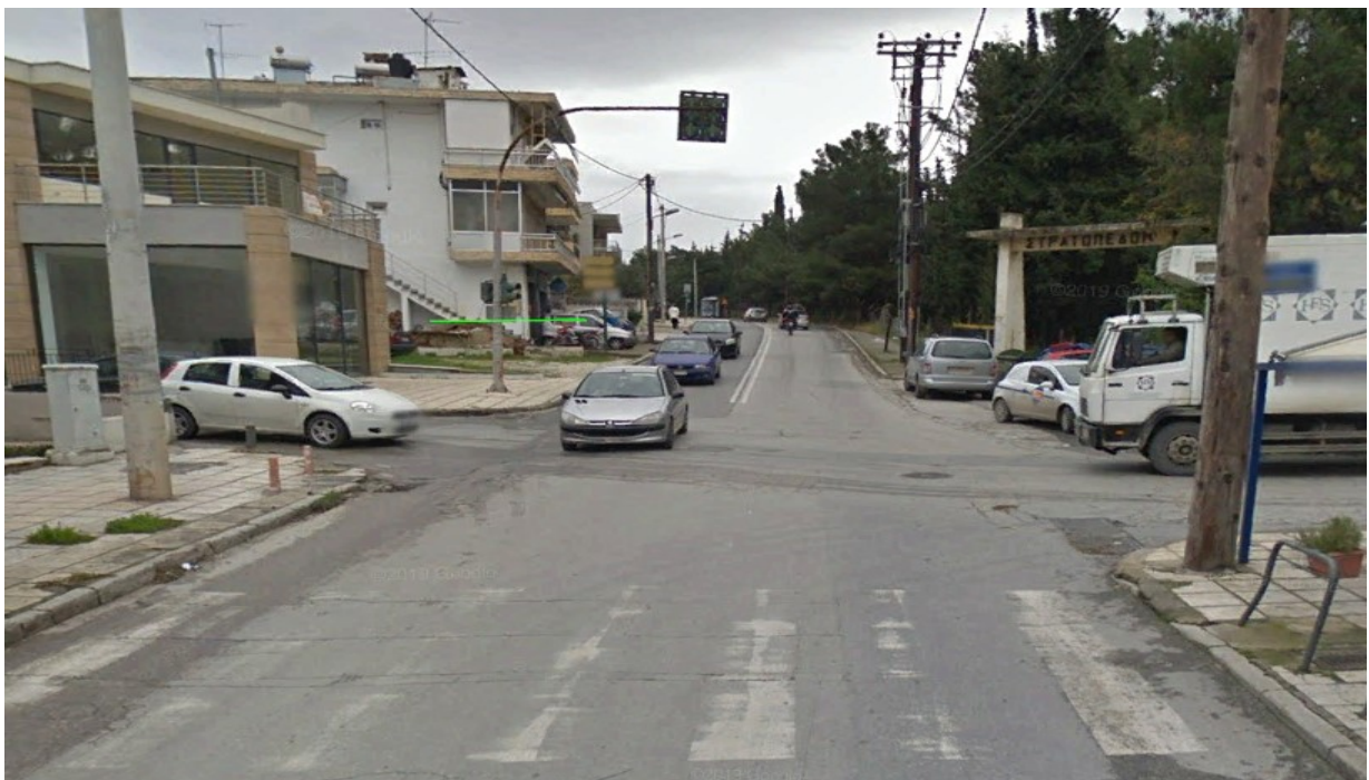
Φωτό 3: Το νότιο όριο του υπό μελέτη τμήματος στο ύψος της διασταύρωσης με την οδό Αλκιβιάδου (πρόσβαση στα δεξιά). Λήψη της φωτο στην κατεύθυνση προς την Εσωτερική Περιφερειακή Οδό Θεσσαλονίκης, προς το βόρειο άκρο του τμήματος.
