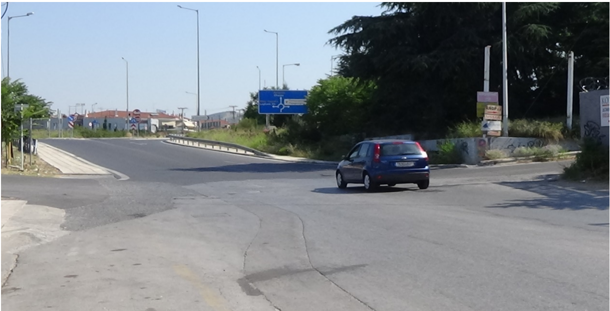
Φωτό 1: Η πρόσβαση του υπό μελέτη τμήματος της οδού Λεωφόρος Στρατού στον κυκλικό κόμβο (round about) με την Εσωτερική Περιφερειακή Οδό Θεσσαλονίκης.
