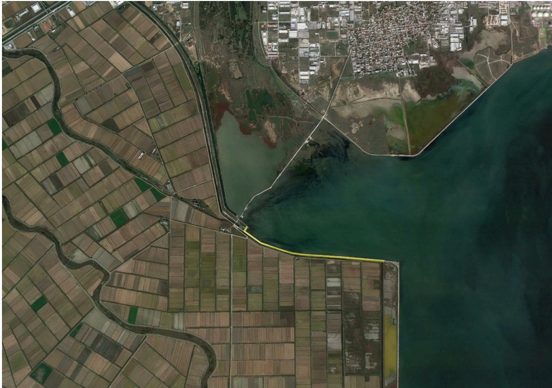
Εικόνα 3: Θέση έργου τοποθέτησης πασσαλοσανίδων σε δύο φάσεις (1993, 2002) [Πηγή: Google Earth Pro]
