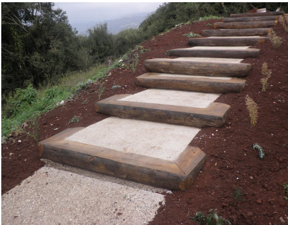
Εικ. 2: Αρχική κατασκευή βαθμίδων από σταθεροποιημένο χωμάτινο δάπεδο
