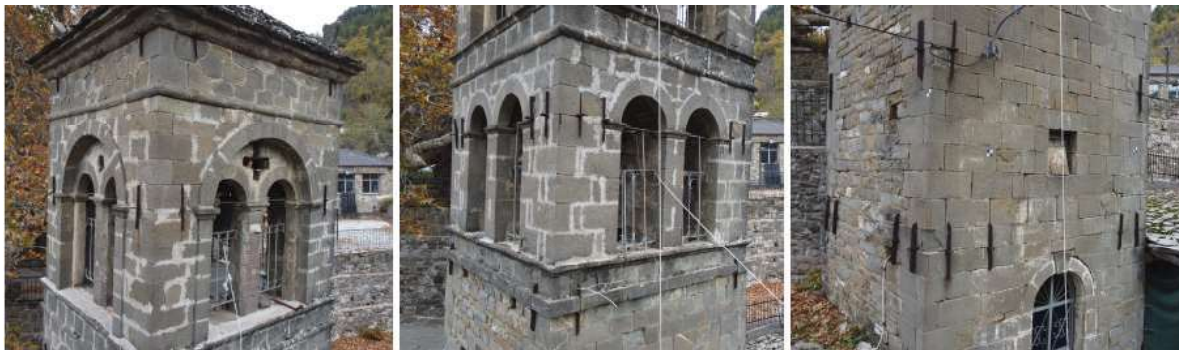
Εξωτερικές αγκυρώσεις μεταλλικών λαμών καθ' ύψος (Τ. Κουιμτζόγλου, 2022)
