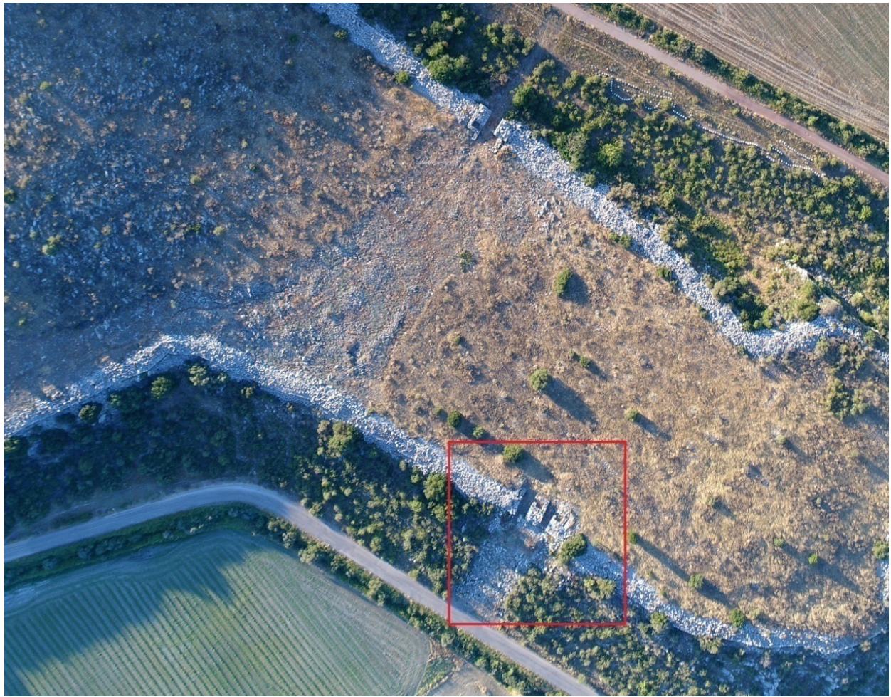
Άποψη του ΝΑ Διπύλου. Σημειώνεται η περιοχή εκτέλεσης του έργου
