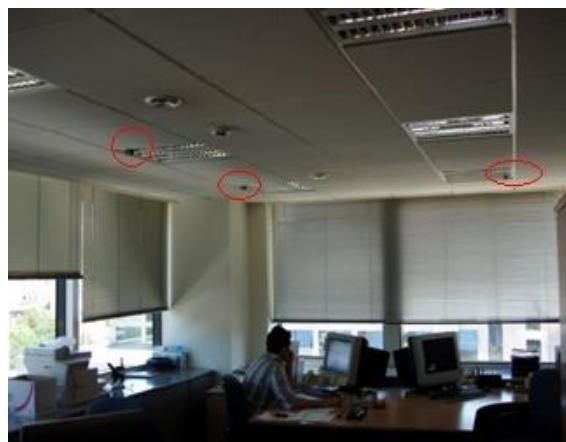
Σχήμα 13-6: (Αρ) Κοινός αισθητήρας φωτισμού παρουσίας ο οποίος ελέγχει ομάδα φωτιστικών σωμάτων. Στη συγκεκριμένη περίπτωση ο μελετητής ελέγχει ποια φωτιστικά ελέγχονται από αυτόν (Δεξ). Αισθητήρες φωτισμού οι οποίοι ελέγχουν ατομικά τα φωτιστικά σώματα στη ζώνη φυσικού φωτισμού. Στην προκειμένη περίπτωση εκτός από τη ξεχωριστή καταγραφή αυτών των φωτιστικών σωμάτων.
