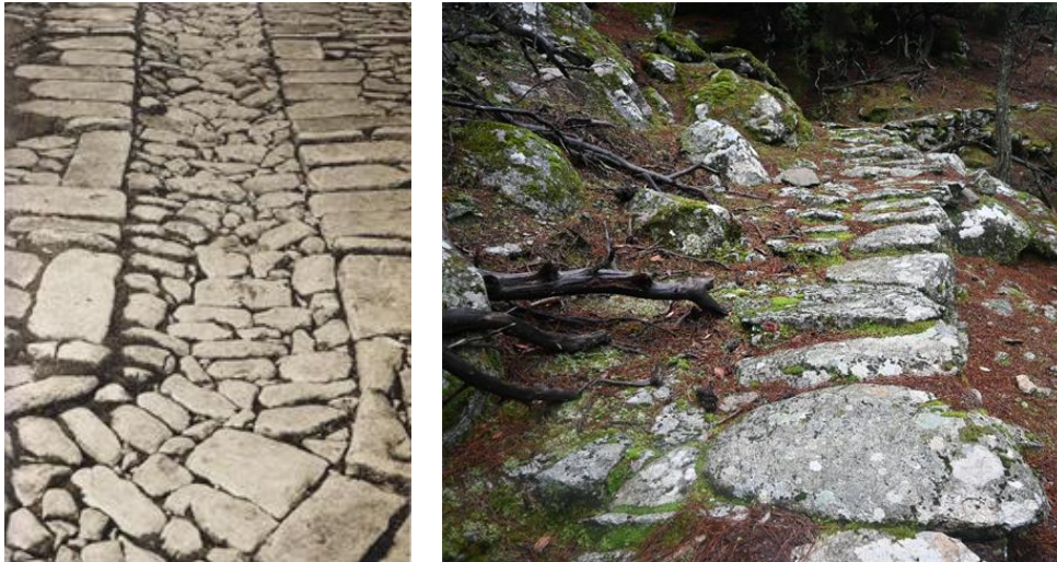
Εικόνα 6.3 Η λογική της διαφοροποίησης των κατασκευαστικών τεχνικών ανάλογα με το διαθέσιμο υλικό, υπακούοντας πάντα στη λειτουργικότητα των λιθόστρωτων. Οι ντουσεμέδες της Μυτιλήνης, φτιαγμένες με λευκές πλάκες ασβεστολιθικές (αριστερά) και οι ντουσεμέδες της Ικαρίας από τοπικό γνεύσιο. Πηγές φωτογραφιών: τοπική ιστοσελίδα Μυτιλήνης / Γρηγόρης Κουτρόπουλος.
