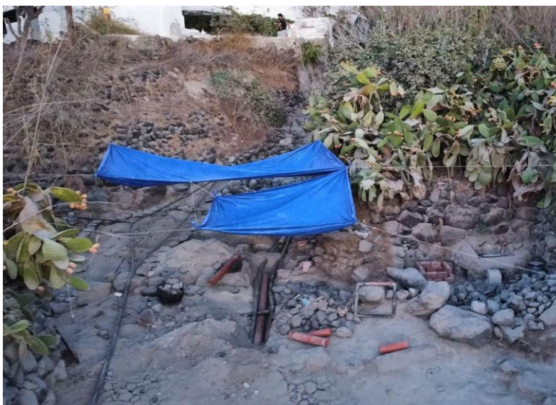
Εικόνα 5.4 Εγκατάσταση δικτύων κοινής ωφέλειας σε λιθόστρωτο στην Αγριλιά της Θηρασίας. (Φωτογραφία: Γρηγόρης Κουτρόπουλος)
