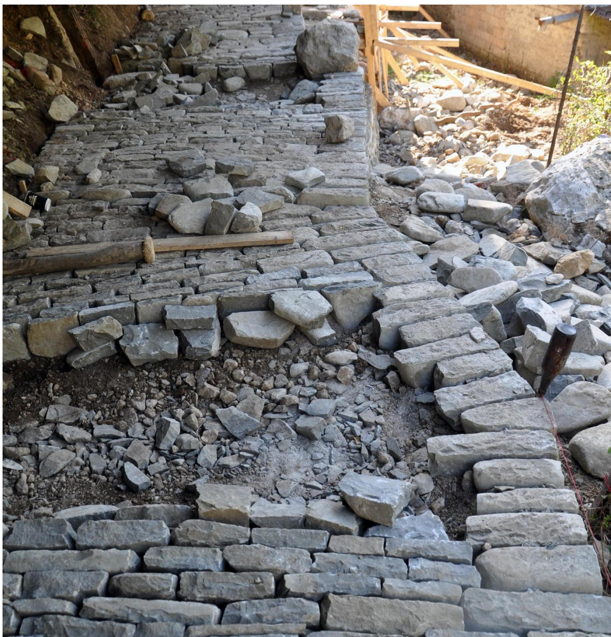
Εικόνα 5.2 Τοποθέτηση του καταστρώματος στα ήδη διαμορφωμένα πλευρικά όρια λιθόστρωτου στην Πλάκα Τζουμέρκων. (Φωτογραφία: Ίωνας Σκλαβούνος)
