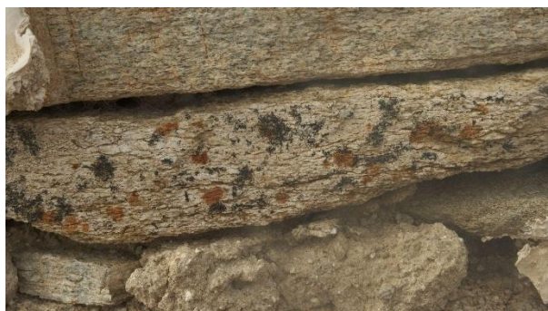
Εικόνα 6.5 Διαβάζοντας διαφορετικούς γρανίτες στις κατασκευές της Δήλου (δεξιά). Ο γρανίτης από την Ρήνεια θεωρείται καλύτερης ποιότητας και ξεχωρίζει από αυτόν της Δήλου λόγω της ύπαρξης άστριων (mica), ορυκτών που λαμπυρίζουν. Φωτογραφία: Ιωάννα Ντούτση.
