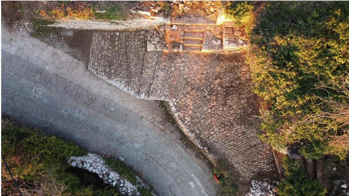
Εικόνα 5.8 Νέα λιθόστρωτη ραμπόσκαλα στην είσοδο κηρυγμένου διατηρητέου κτηρίου στην Κόνιτσα. (Φωτογραφία: Γρηγόρης Κουτρόπουλος)
