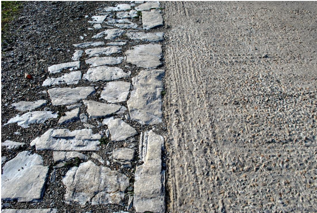
Εικόνα Β.1. Κάλυψη λιθόστρωτου από τσιμεντοστρωμένο δρόμο, Αμοργός. (Φωτογραφία: Γεωργία Κανελλοπούλου)
