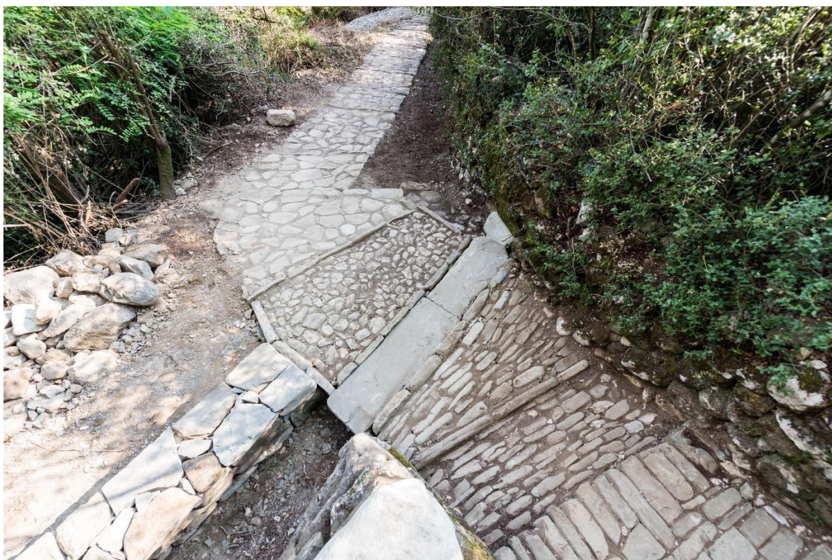
Εικόνα 5.7 Λιθόστρωτο στην Πλάκα Τζουμέρκων με ποικιλία τυπολογιών καταστρώματος. (Φωτογραφία: Γιώργος Δημητρακόπουλος)
