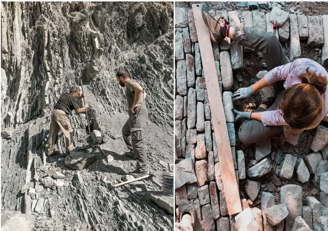
Εικόνα 6.12 Από την γεωλογική έκφραση του φλύσχη, στην ‘στρωσιγενή’ δομή των καλντεριμιών από συμπαγή ψαμμίτη στο καλντερίμι που οδηγεί στην Γέφυρα της Πλάκας, στα Τζουμέρκα. (Φωτογραφίες: Γρηγόρης Κουτρόπουλος, Αθηνά Αποστόλου)
