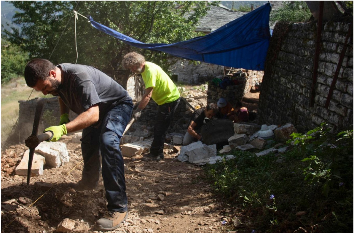
Εικόνα 5.1 Διαμόρφωση του εδάφους με μεγαλύτερο βάθος των πλευρικών ορίων σε προς κατασκευή λιθόστρωτο στην Αρίστη Ζαγορίου. (Φωτογραφία: Ελένη Μητροπούλου)
