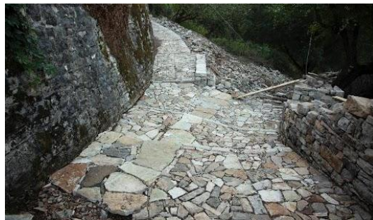
Εικόνα 6.10 Η ιδιότητα της θραύσης είναι σημαντική και για την κατασκευή των ξερολιθικών καλντεριμιών (κάτω), όπου συνήθως χρησιμοποιούνται τα υπολείμματα της κατασκευής του συνοδευτικού ξερολιθικού τοίχου (πάνω), όπως σε αυτή την περίπτωση της αποκατάστασης του ξερολιθικού συνόλου εντός του οικισμού στην Αρίστη Ζαγορίου. (Φωτογραφίες: Γρηγόρης Κουτρόπουλος)
