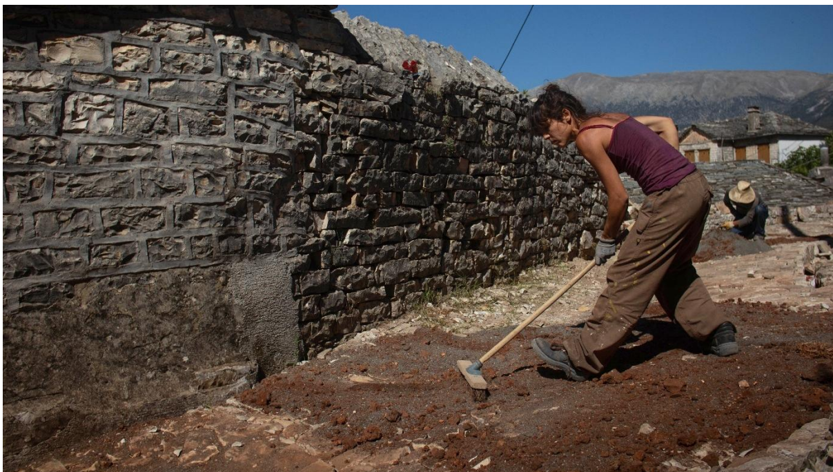
Εικόνα 5.3 Αρμολόγηση λιθόστρωτου στην Αρίστη Ζαγορίου. (Φωτογραφία: Ελένη Μητροπούλου)
