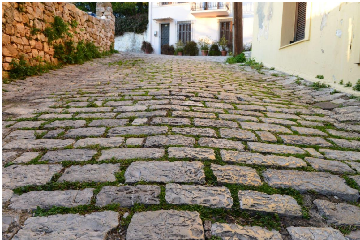
Εικόνα 5.9 Εφαρμογή παραδοσιακού λιθόστρωτου στο ιστορικό κέντρο της πόλης της Ναυπάκτου. (Φωτογραφία: Γρηγόρης Κουτρόπουλος)
